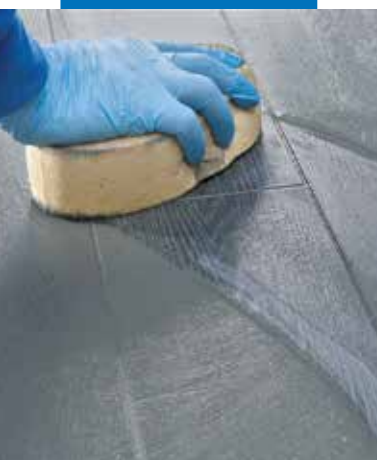
Čištění a konečná úprava spár v dlažbě typu gres tvrdou houbou z celulózy
