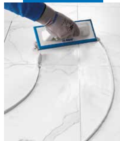
Nanášení Ultracoloru Plus gumovou stěrkou na dlažbu typu gres s efektem mramoru
