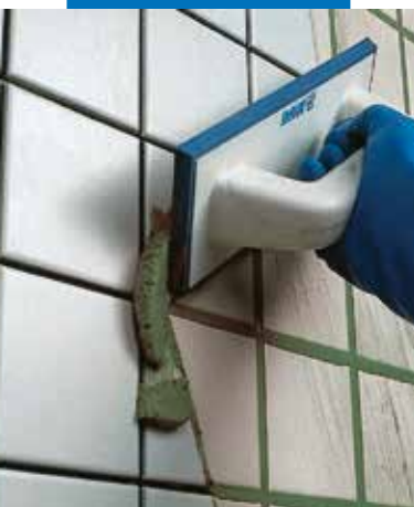
Nanášení Ultracoloru Plus gumovou stěrkou na obklad
