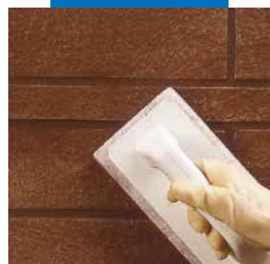
Čištění spár se Scotch-Brite® (částečně ztuhlý výrobek)
