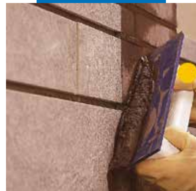
Nanášení Ultracoloru Plus gumovou stěrkou na stěnu
