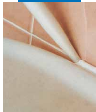
Utěsnění sanitárních předmětů
