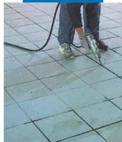
Strojní výplň spár Mapesilem AC v keramické dlažbě
