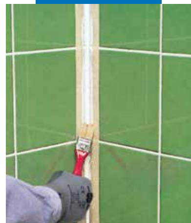
Vyhlazení povrchu spáry saponátovým roztokem a štětcem
